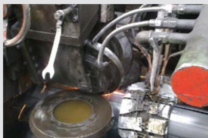
Supervisión de la temperatura de las coronas de tubería antes del soldado
