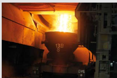
Supervisión del revestimiento refractario de un vagón caldero de escorias mientras sale por la fábrica
